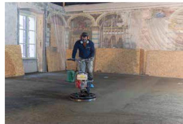
pletamento degli impianti, il getto del pavimento del Salone, la posa delle finestre ed il perfezionamento delle rasature. È stato quindi attivato il riscaldamento, che ha permesso di rilevare scarse dispersioni del cappotto.
